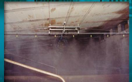
Il ricorso a impianti fissi di nebulizzazione dotati di centralina a microprocessore riprogrammabile consente di effettuare interventi di **virkonizzazione** uniformi in tutto l'allevamento più volte al giorno
